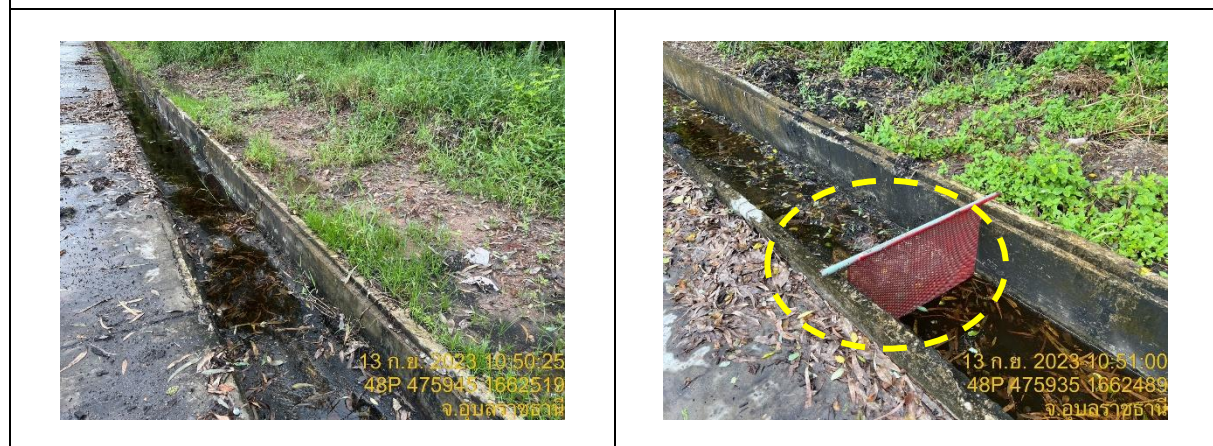
รูปที่ 30 รางระบายน้ำฝนโดยรอบลานและอาคารเก็บเชื้อเพลิงและตะแกรงดักเศษฝุ่น
