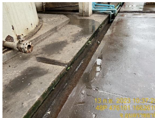
รูปที่ 36 รางรวบรวมน้ำฝนของโครงการ
