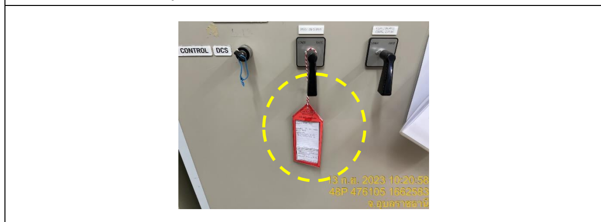
รูปที่ 77 การล็อกกุญแจแขวนป้าย (Lock Out-Tag Out)
